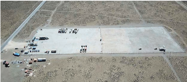
Obras en la extensión de área en el Recinto Aduanero de Lagunas –Zona Tambo Quemado
