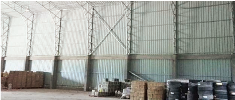
Construcción de almacén en Campo Pajoso - Yacuiba
