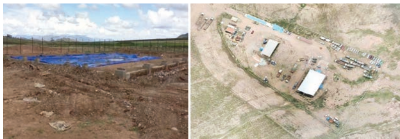
Recinto Aduanero construido por ALBO S.A. en Yamparaez - Sucre
