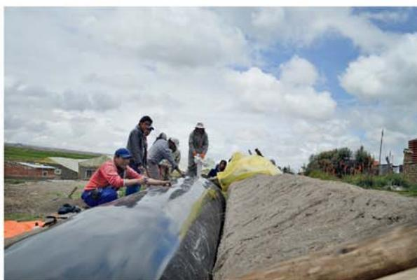
Uno de los biodigestores instalado en el altiplano pazeño.
